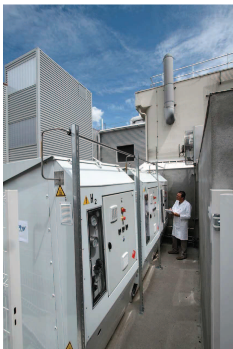
Image : réservoir de stockage de 15kg d'hydrogène de McPhy implanté sur la plateforme de tests du Liten. © P.Avavian/CEA
